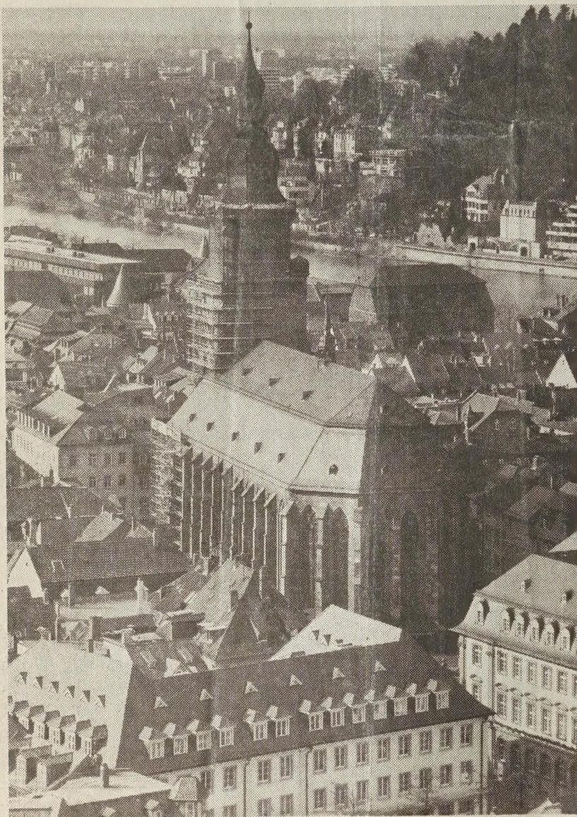
DIE HEILIGGEISTKIRCHE in Heidelberg wird bis 1995 umfassend saniert. Turm und Westportal des gotischen Bauwerks sind bereits eingerüstet. Die Fassade der bedeutendsten evangelischen Kirche in Baden ist so stark zerstört, daß sich an einigen Stellen Sandsteinbrocken lösten. Die Kosten der Restaurierung werden auf acht Millionen Mark veranschlagt. Einen kleinen Teil davon tragen Bund und Land.
