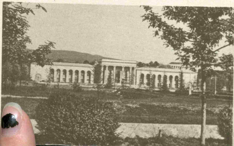
Ванное здание источника № 6.
